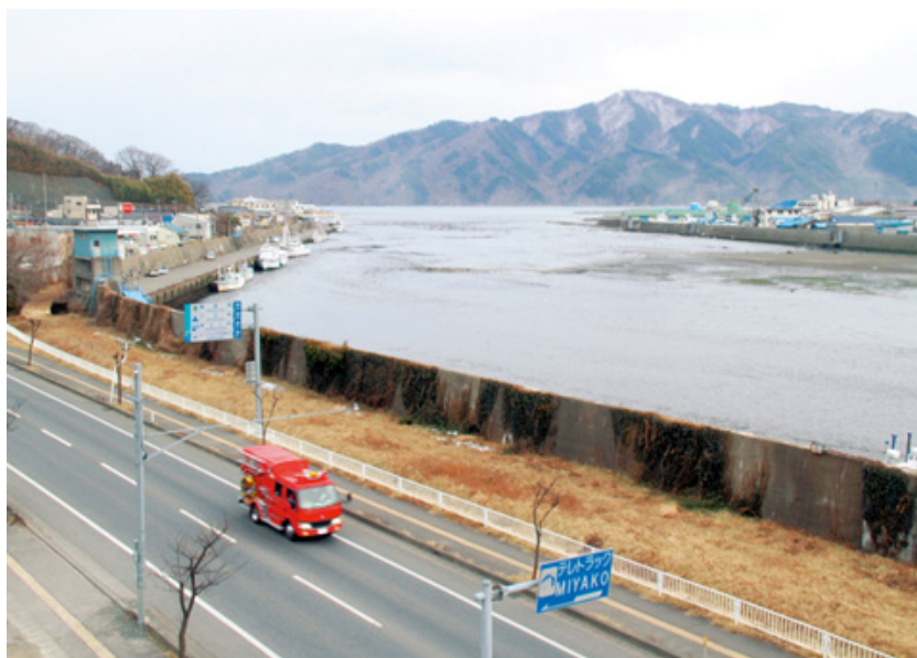
写真1 3月11日15時18分。底が見えるほど潮が引いた閉伊川。 避難を呼び掛ける消防車が防波堤沿いを走る
